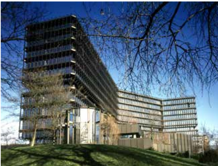
Fig. 1 EOB München, Isar-gebouw
