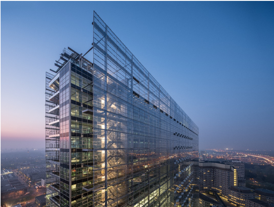
Abbildung 6 – EPA Den Haag, New Main
